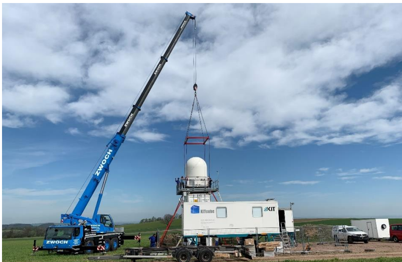
Mobile Messinfrastruktur KITcube: Mithilfe eines Autokrans wird das Niederschlagsradar im Müglitztal/Sachsen installiert. (Foto: Dr. Andreas Wieser, KIT)
