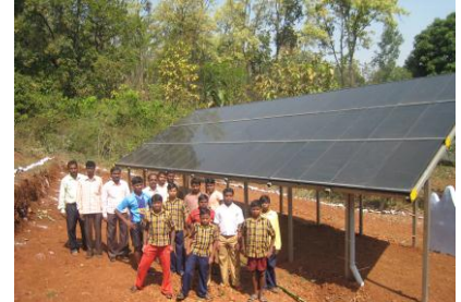
Die fertige Photovoltaikanlage in Gonasika (Foto: EWB)
