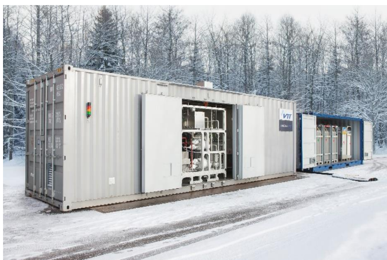
Die kompakte Pilotanlage im SOLETAIR Projekt ist für die dezentrale Produktion konzipiert, passt in einen Schiffcontainer und lässt sich modular erweitern. (Bild: VTT)
