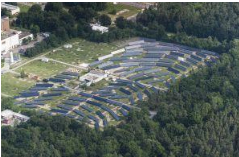
Technologien wie der Solarspeicherpark des KIT speisen dank Batterien und moderner Informationstechnologie Sonnenstrom verlässlich ins Stromnetz ein. (Bild: Markus Breig, KIT)
