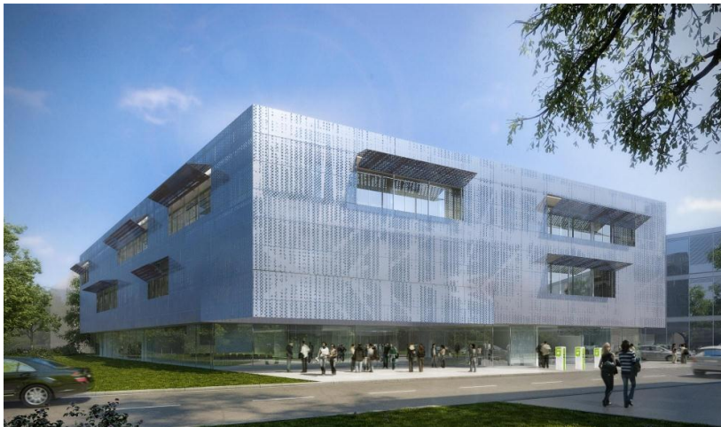
Neues Gebäude für die Batterieforschung: Der HIU-Bau soll bis Ende 2013 bezugsfertig sei. (Bild: Vermögen und Bau Baden-Württemberg)
