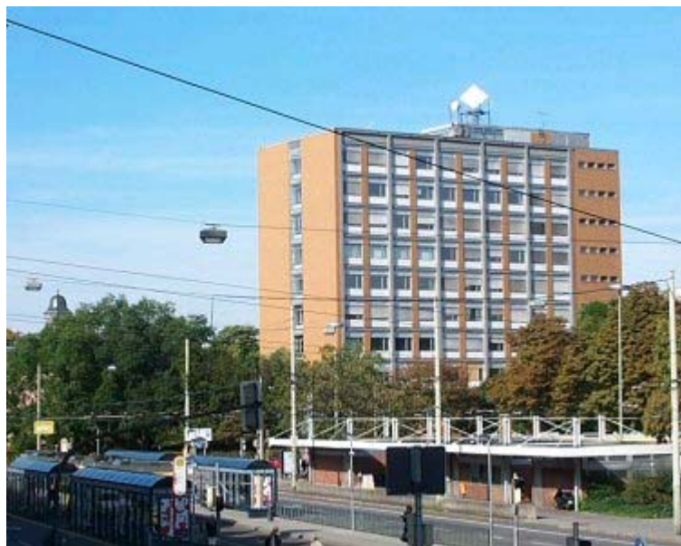
Neues Bauingenieurgebäude (Geb. 10.50) am Durlacher Tor
