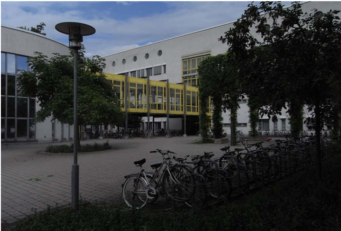
Forschungszentrum Umwelt, Gebäude 50.40
