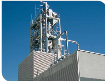
Schnellpyrolyse in der bioliq®-Anlage: Hier wird Biomasse in ein transportfähiges flüssiges Zwischenprodukt umgewandelt.
