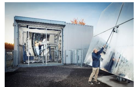
Mithilfe von Flüssigmetalltechnologien kann der Wirkungsgrad eines konzentrierenden solarthermischen Kraftwerks signifikant erhöht werden. Das Foto zeigt die Pilotanlage SOMMER am KIT. (Foto: Amadeus Bramsiepe, KIT)
