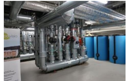
Der Aquiferspeicher am Bonner Bogen übernimmt bis zu 80 Prozent der Wärme- und Kälteversorgung von drei Gebäuden mit einer Gesamtfläche von 60.000 Quadratmetern (Foto: Paul Fleuchhaus, KIT)
